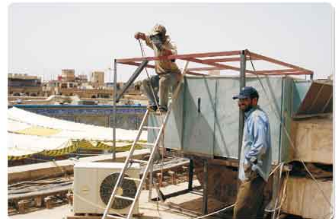
عمل مظلات حديدية لأجهزة التبريد
