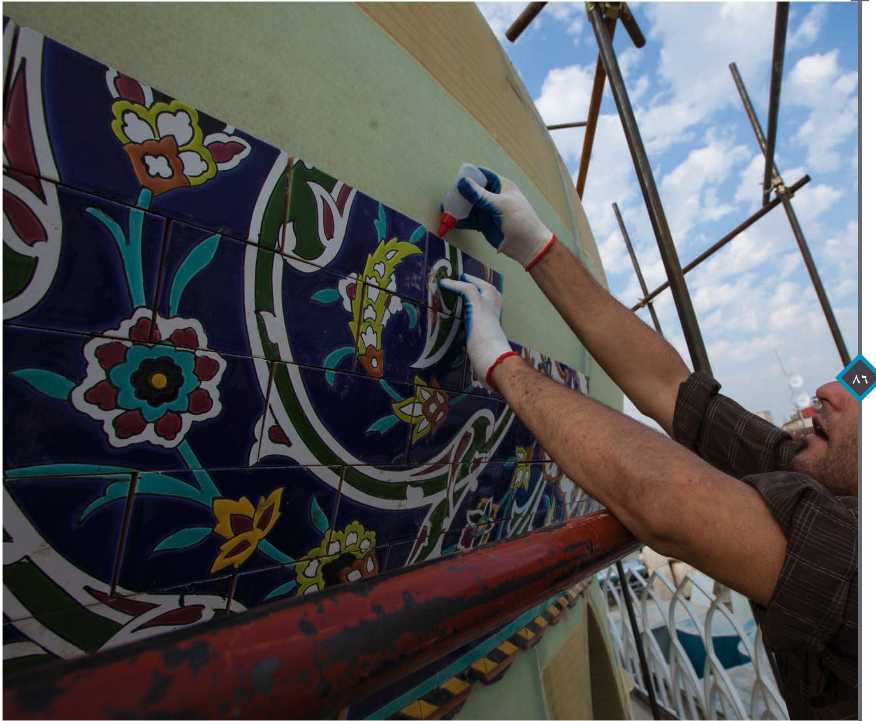
جانب من أعمال تركيب الكاشي الكربلائي
