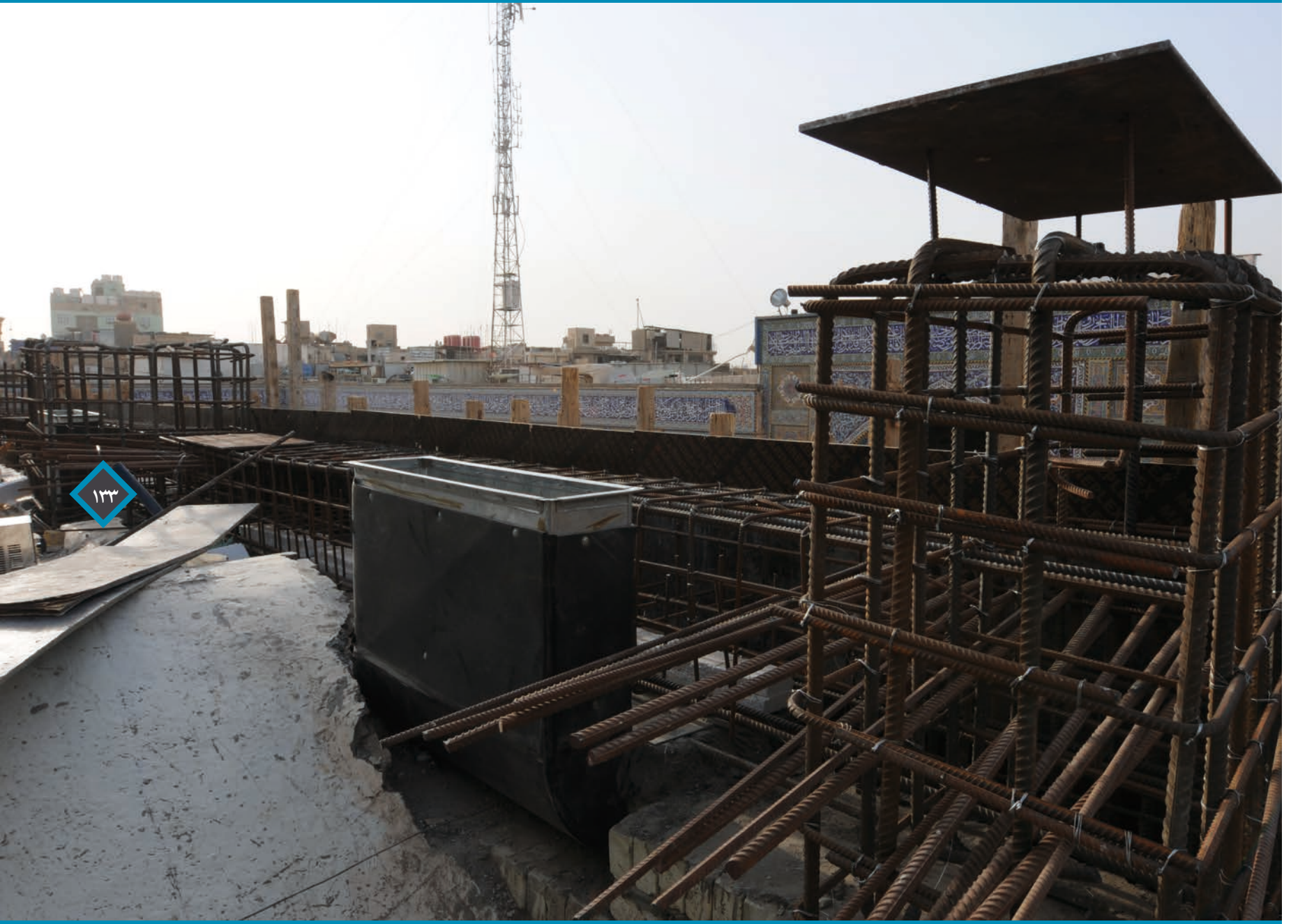
إنشاء الجسور الخرسانية على منشآت السور القديم لرفع السقف الجديد (٢٠١١م)
