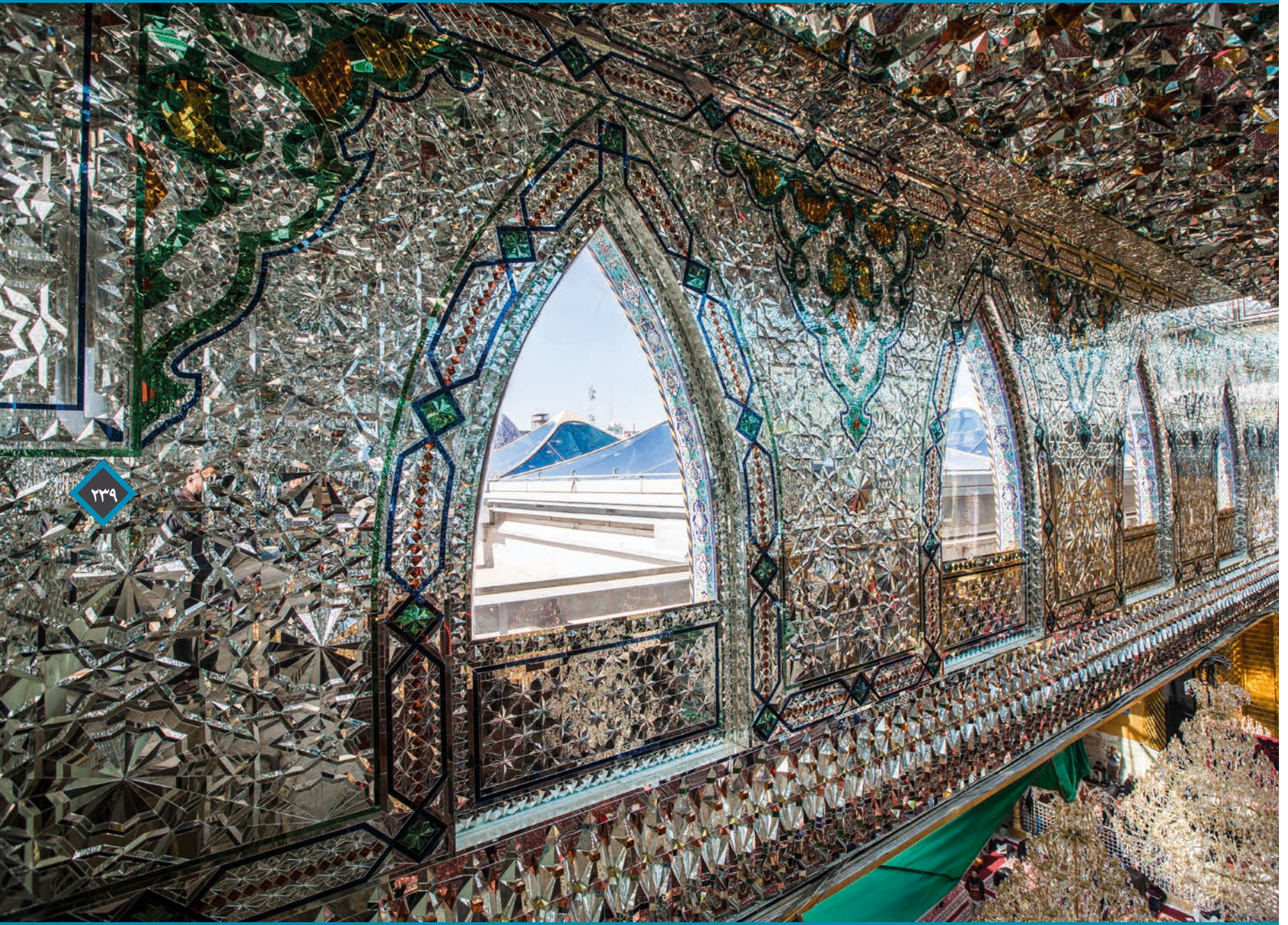
تركيب قطع مرايا الزجاج المقطع هندسيا بأشكال فسيفسائية
