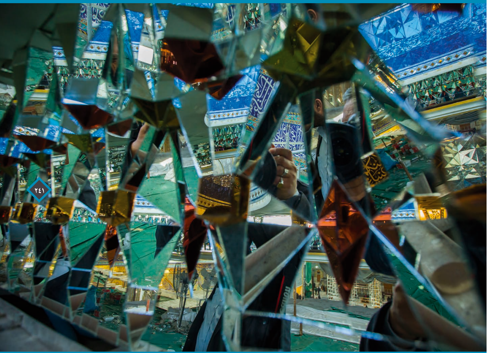
تركيب قطع مرايا الزجاج المقطع هندسيا بأشكال فسيفسائية (٢٠١٣م)
