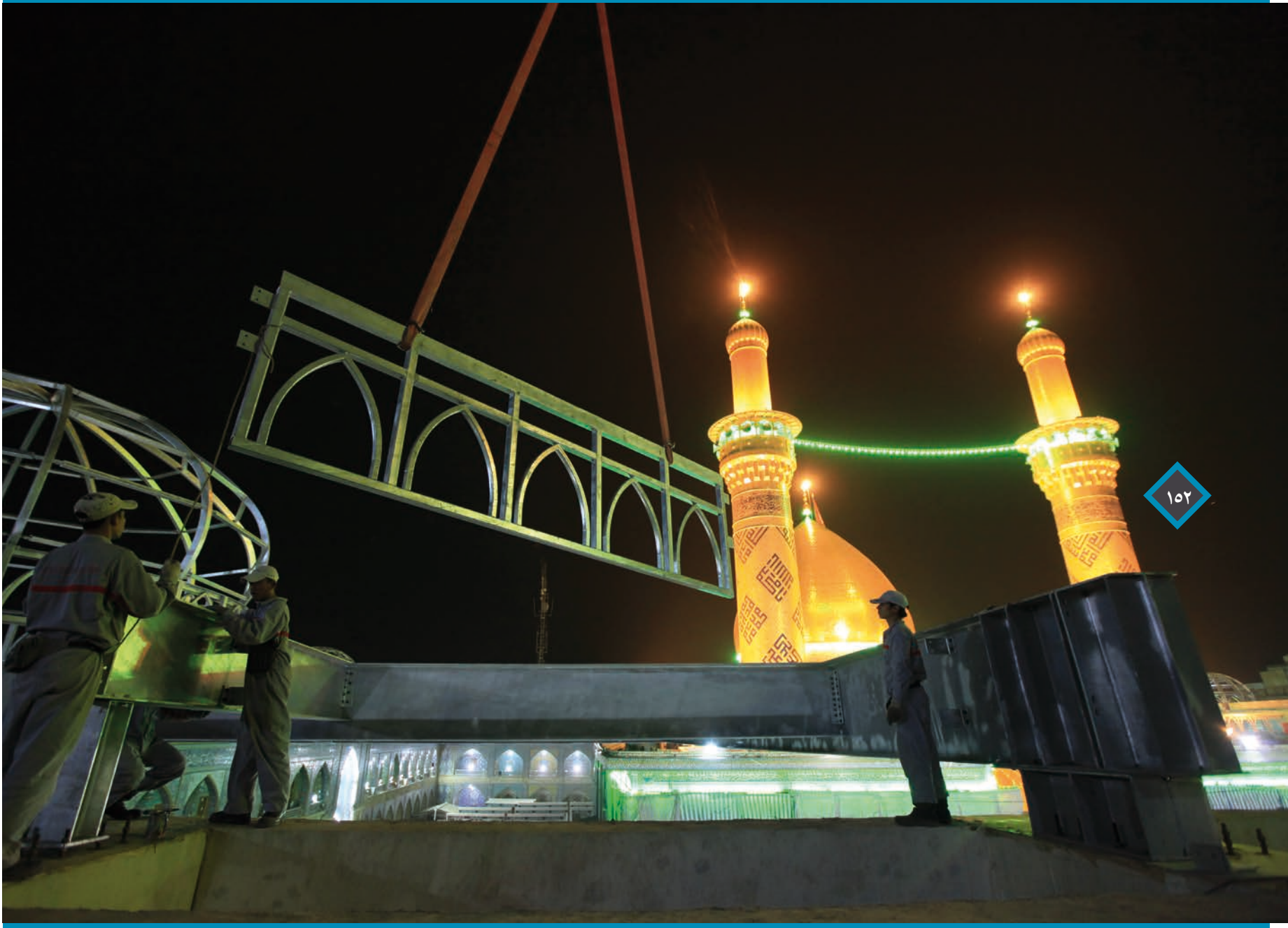
تركيب أجزاء النوافذ و الجسور الحديد عند رفعها للسقف (٢٠١١م)
