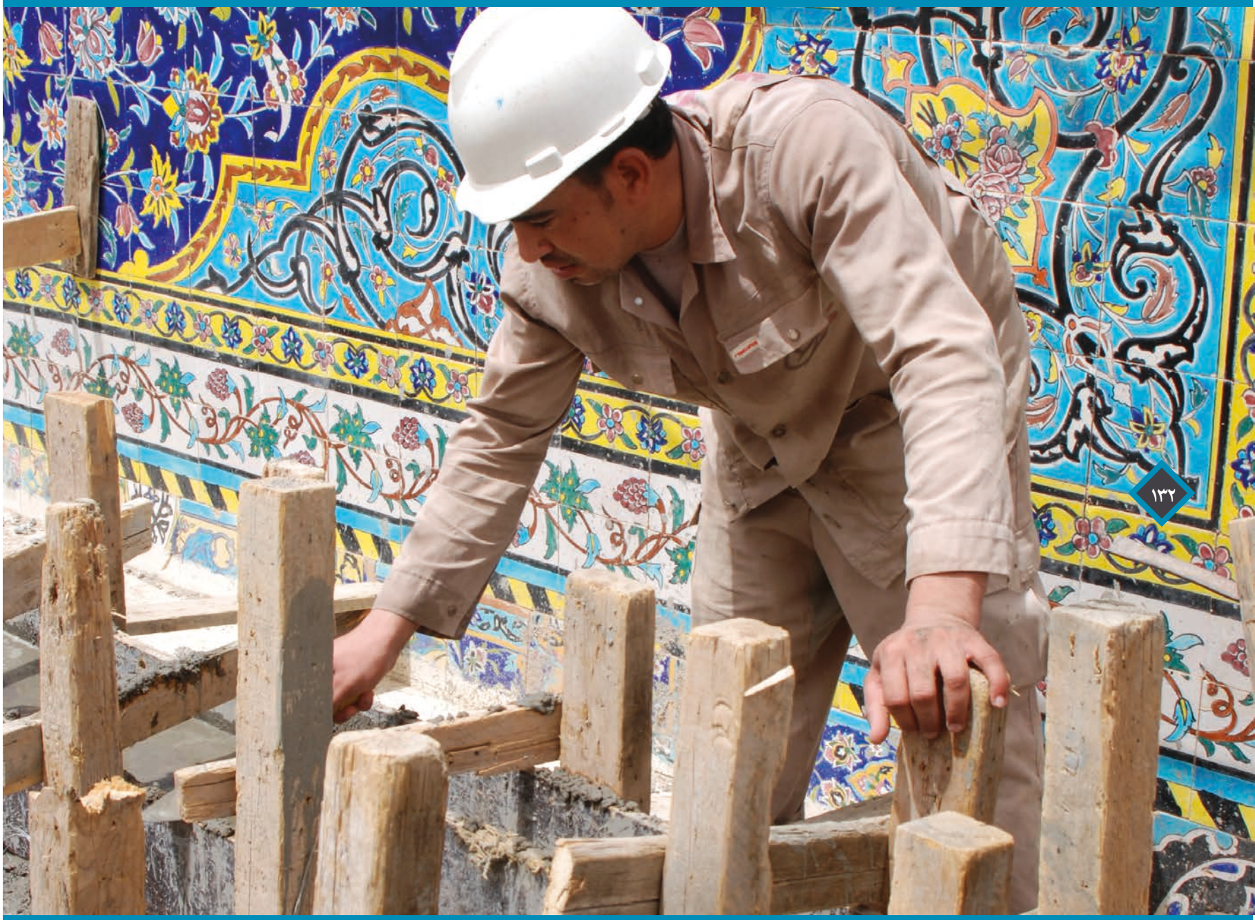
إنشاء الجسور الخرسانية على منشآت السور القديم لرفع السقف الجديد (٢٠١١م)
