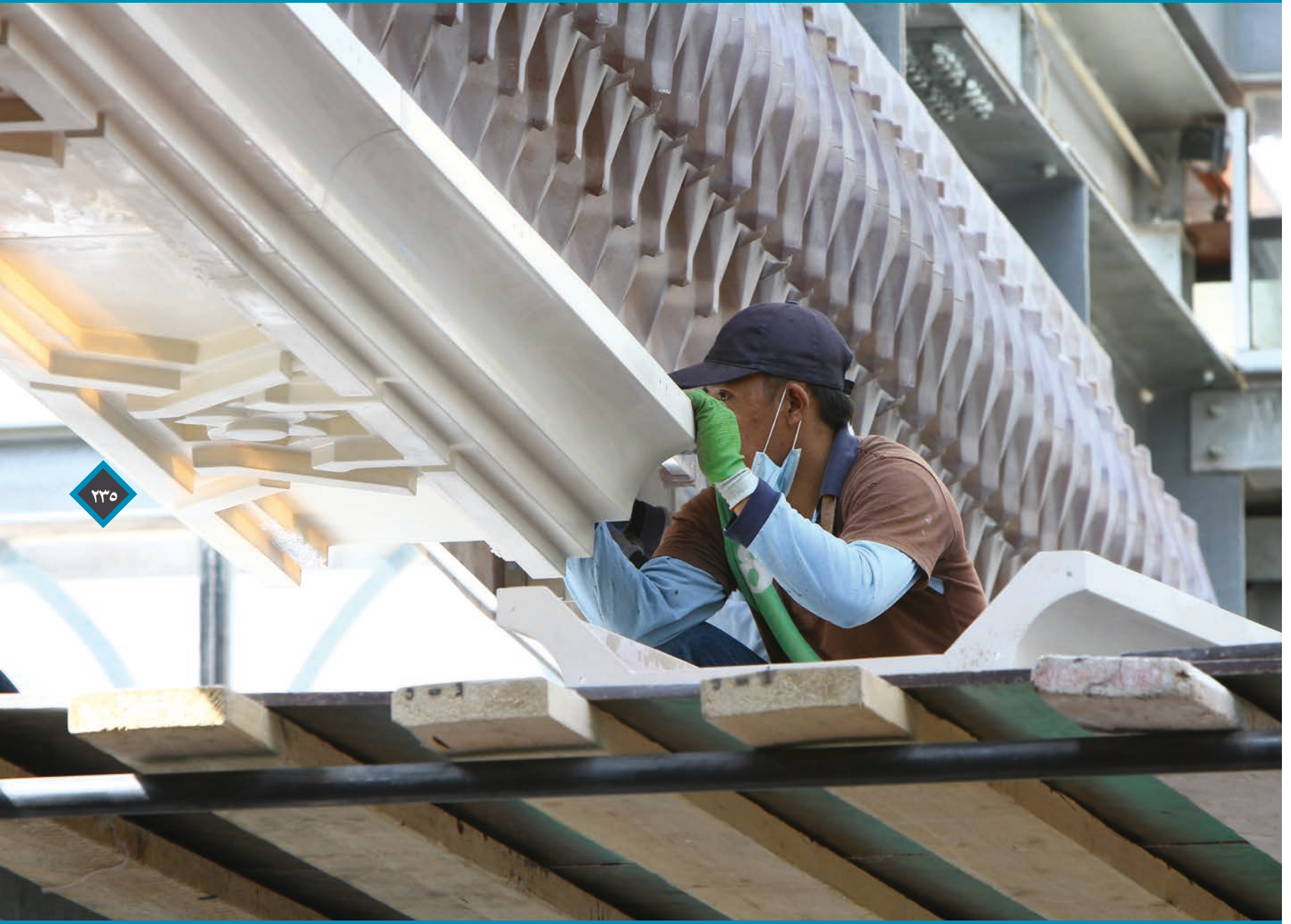
قوالب المقرنصات المصنوعة بمادة الفايبر كلاس (٢٠١٣م)
