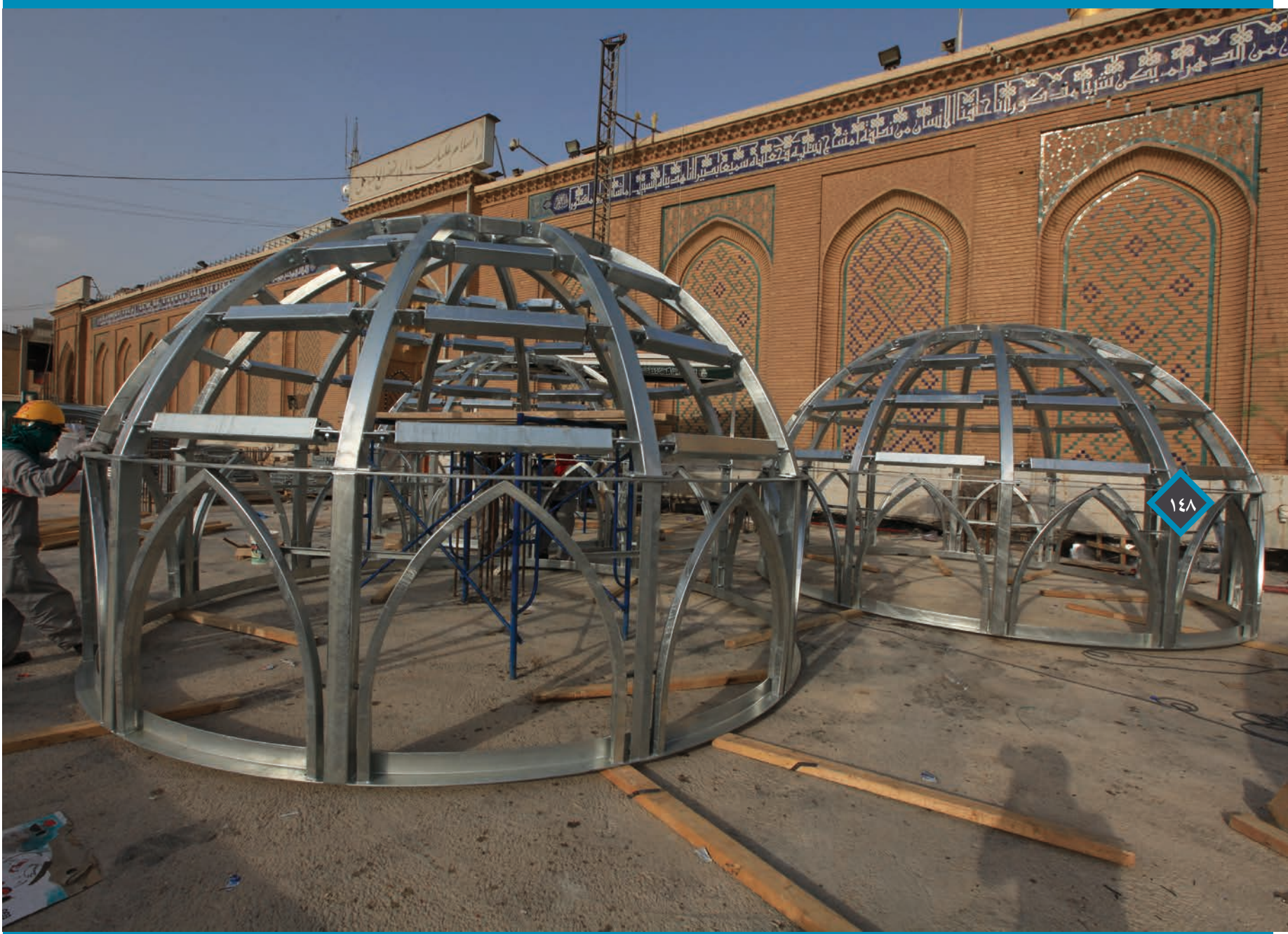
تركيب أجزاء القباب الحديد قبل رفعها للسقف (٢٠١١م)
