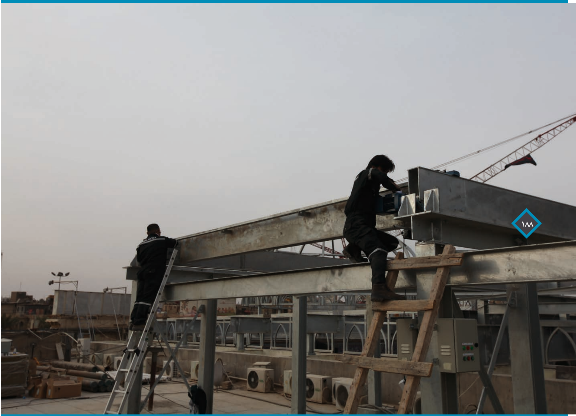
عملية تركيب المحركات الكهربائية الخاصة بتحريك الخيام (٢٠١٢م)
