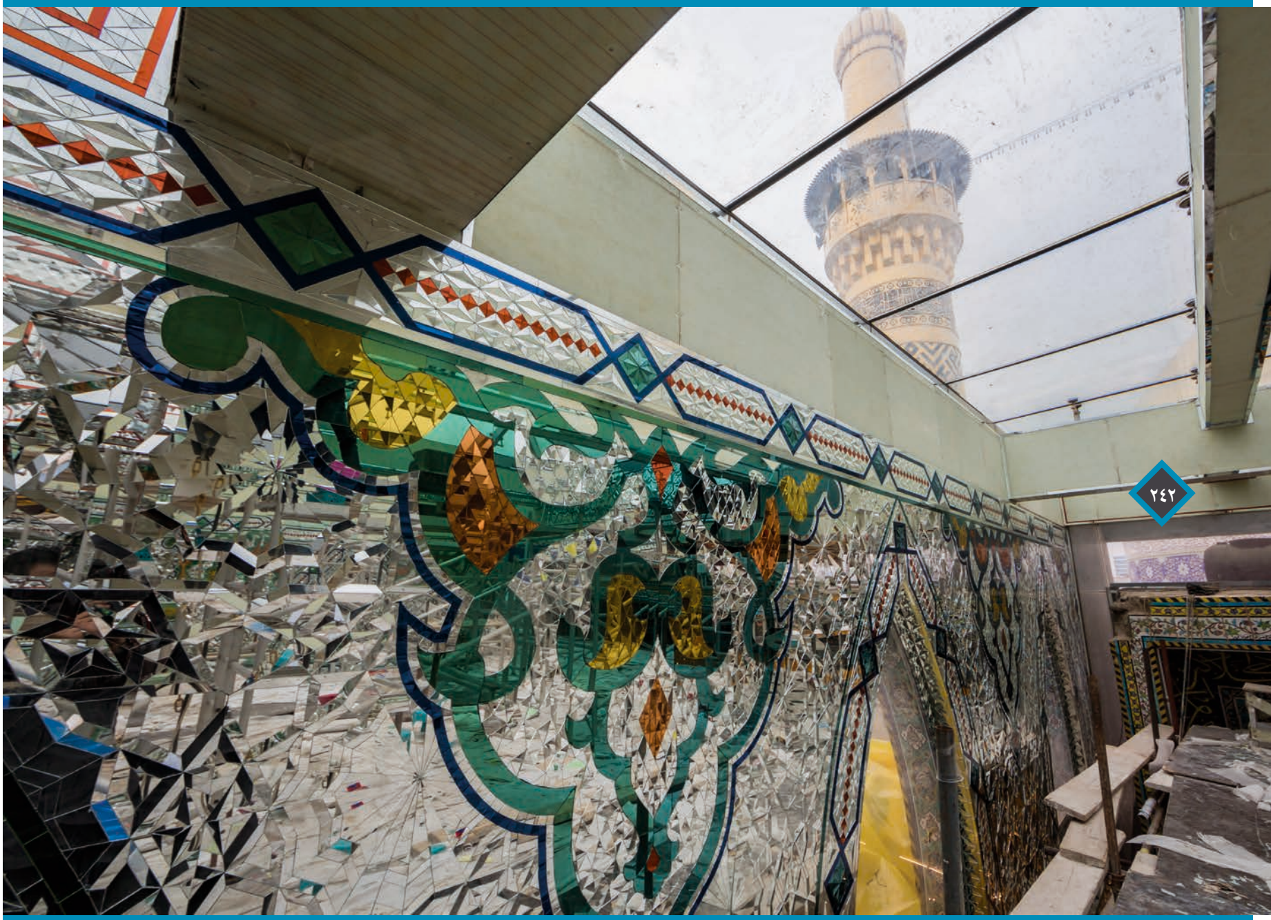
تركيب قطع مرايا الزجاج المقطع هندسيا بأشكال فسيفسائية (٢٠١٦م)
