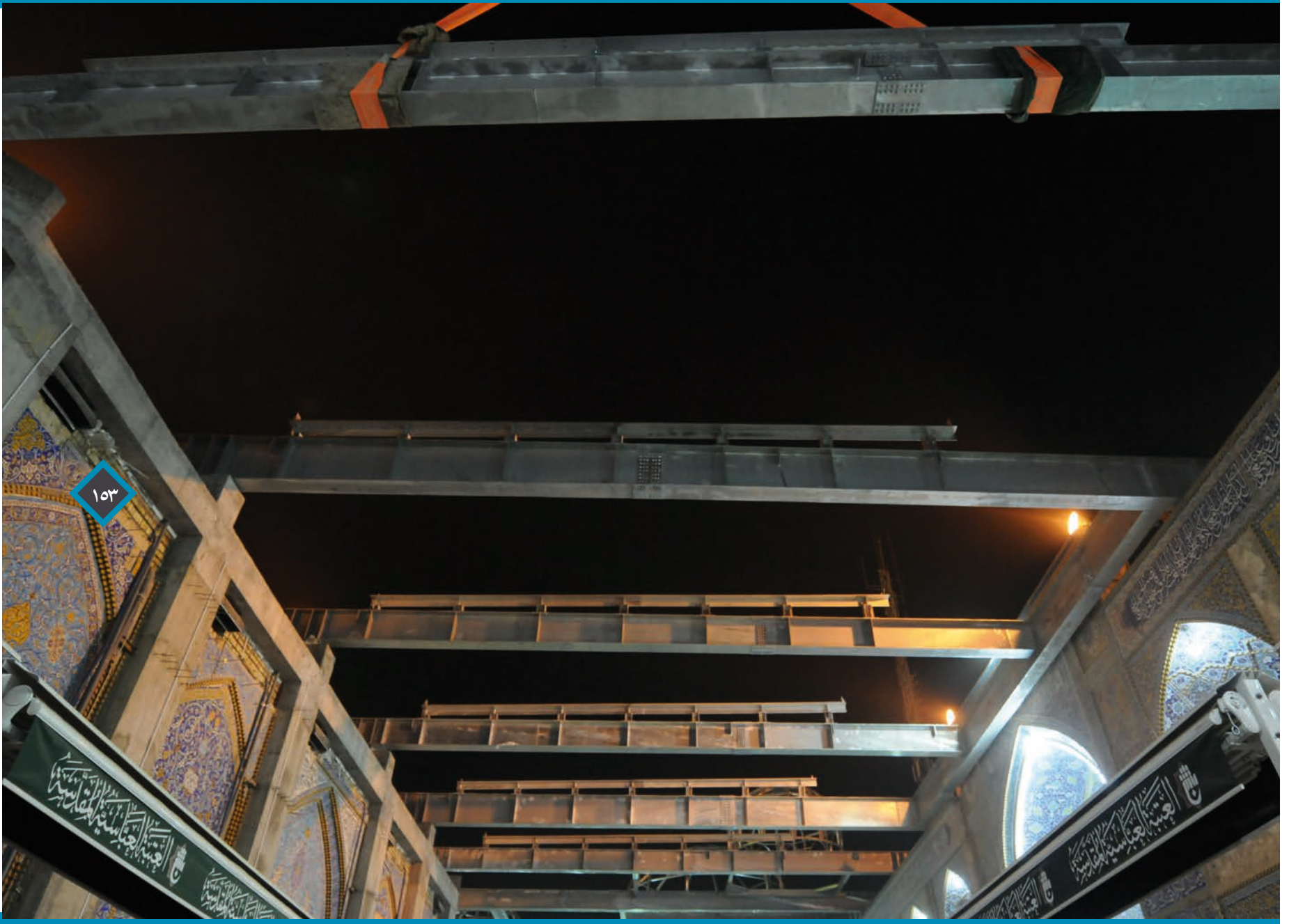
تركيب الجسور الحديد عند رفعها للسقف (٢٠١١م)
