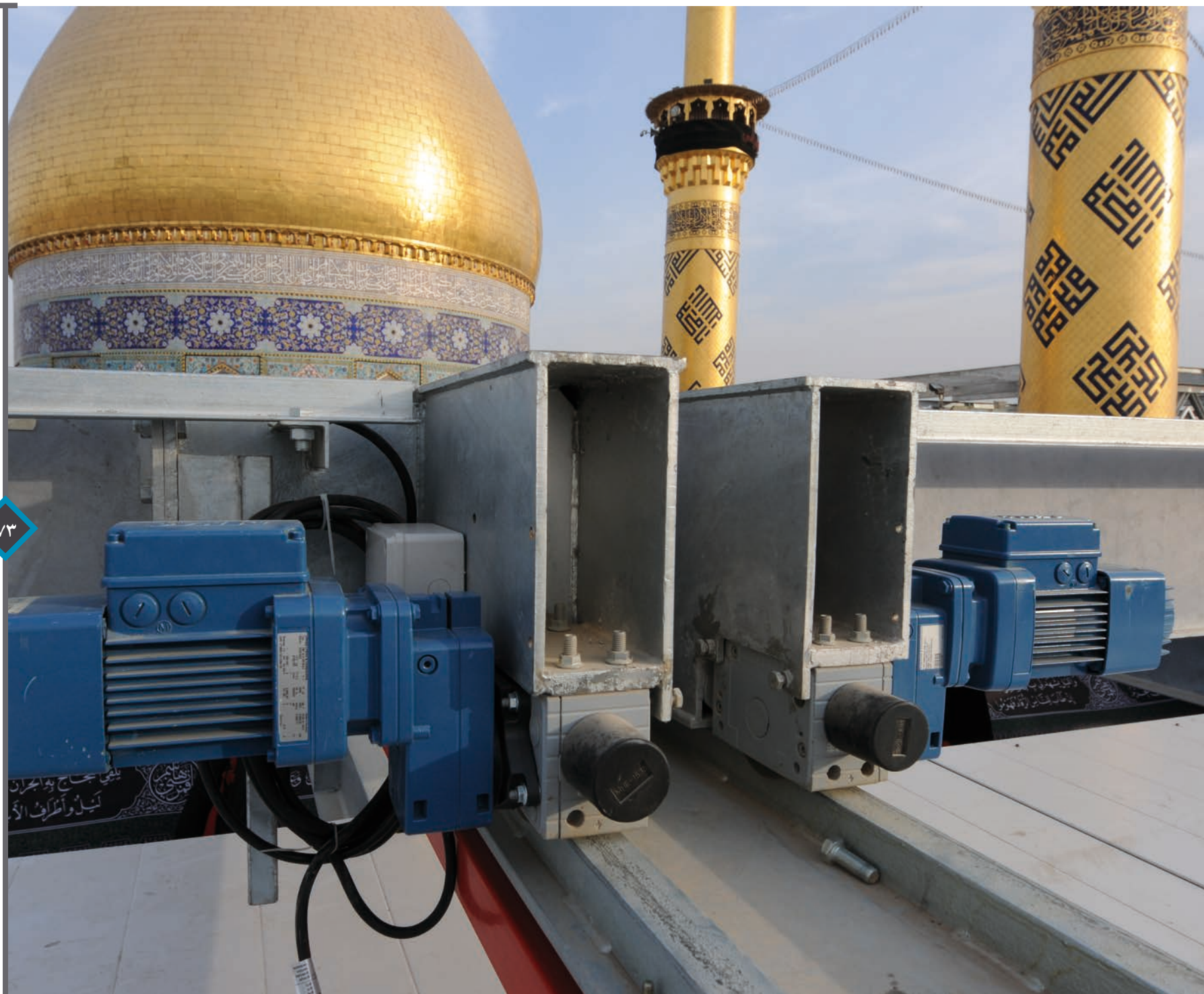
تركيب وربط المحركات الكهربائية الخاصة بتحريك الخيام الزجاجية
