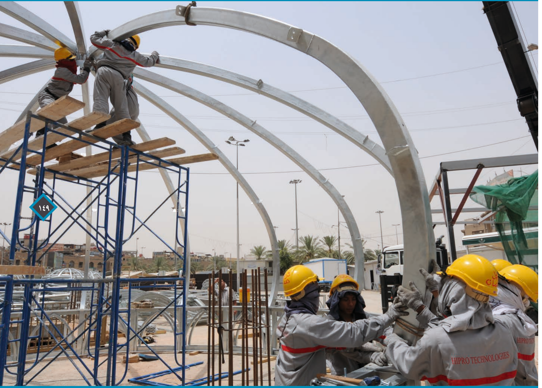
تركيب أجزاء القباب الحديد قبل رفعها للسقف (٢٠١١م)
