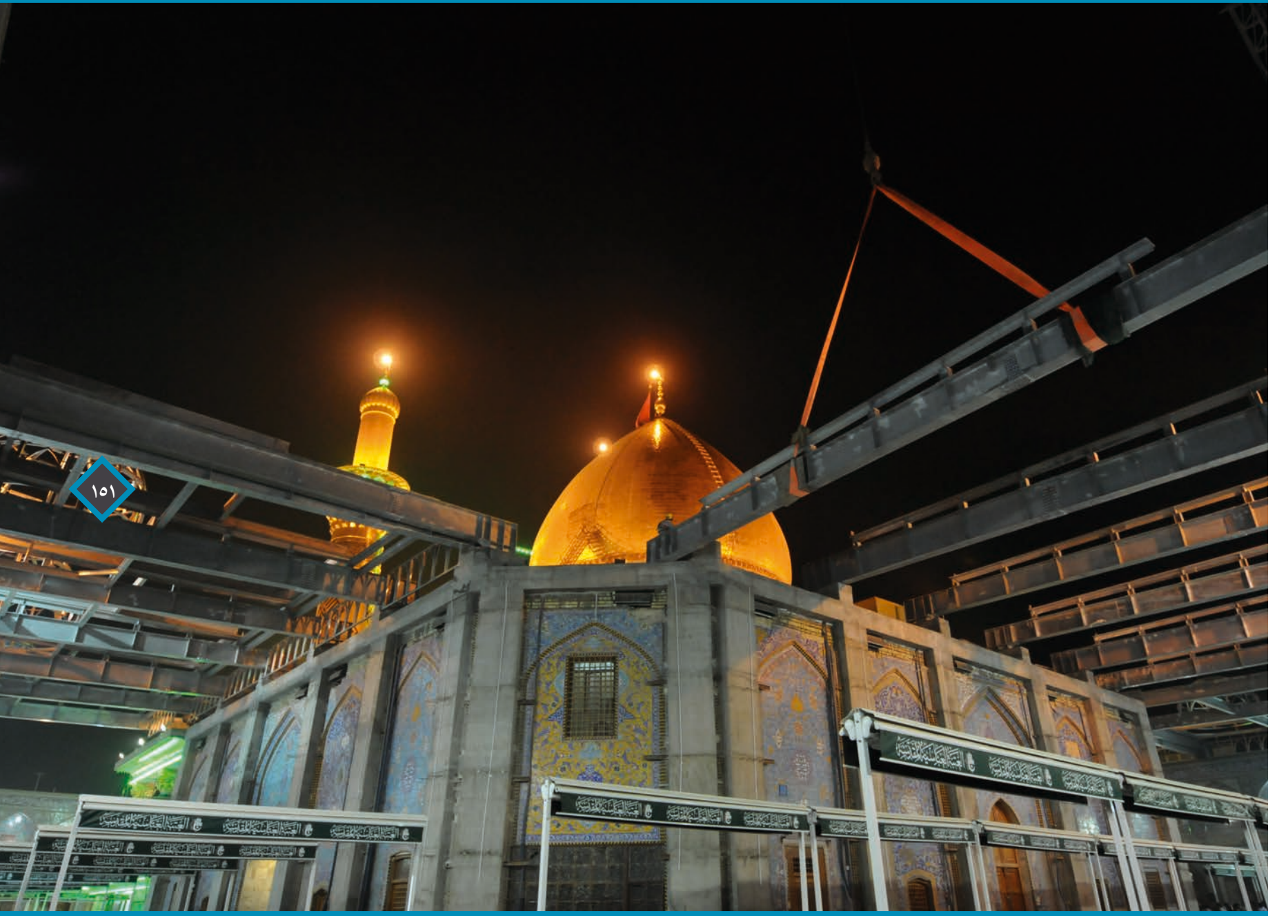
تركيب الجسور الحديد عند رفعها للسقف (٢٠١١م)
