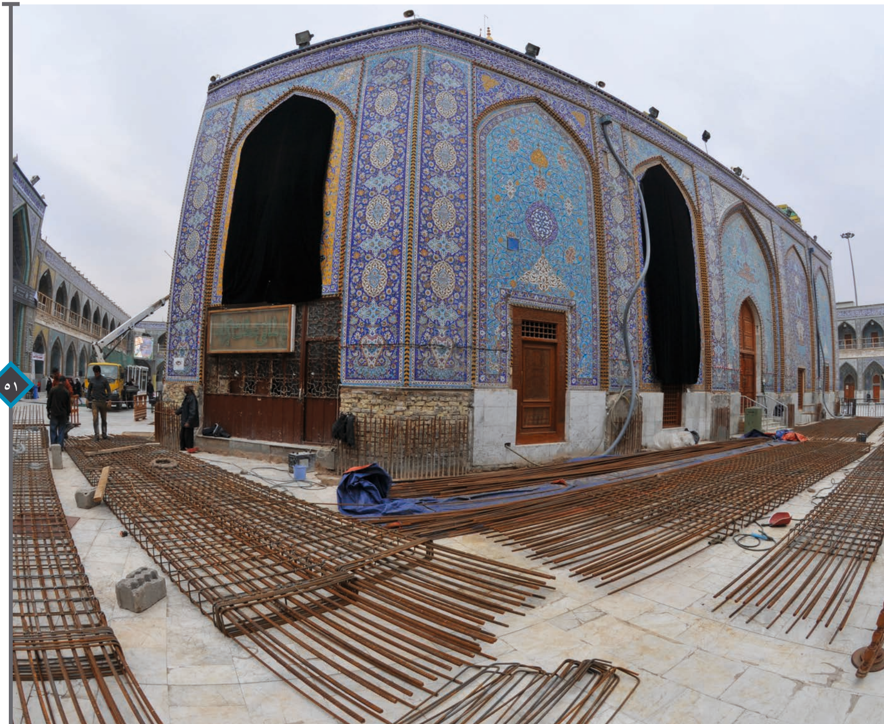
أعمال تقوية سطح جدار الحرم وتهيئة أماكن ربط الجسور
