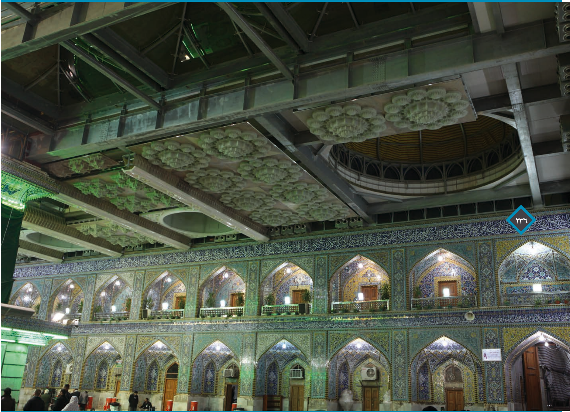
قوالب المقرنصات المصنوعة بإداة الفاير كلاس (٢٠١٣م)
