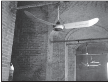
لوح (٥١): العقود المتقاطعة التي تحمل سقوف السراييب في مدرسة اليزدي
