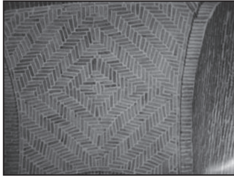
لوح (٥٢): طريقة رصف الحجر في سقف سراديب مدرسة اليزدي
