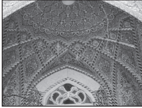
لوحة (١٨): إيوان الغرفة من الداخل وهو مكسو بالقراميد الخزفية بشكل كامل وتظهر فيه المثلثات الكروية الحاملة لسقف الإيوان والزخارف النباتية والإطارات المقطعة التي تصل بين كل جزء
