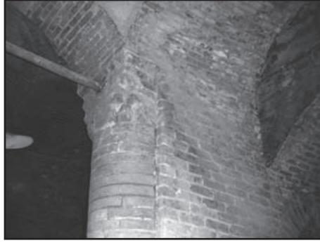
لوح (٤٩): العمود المندمج والمقرنصات التي تكون تاجه في سرداب مدرسة اليزدي
