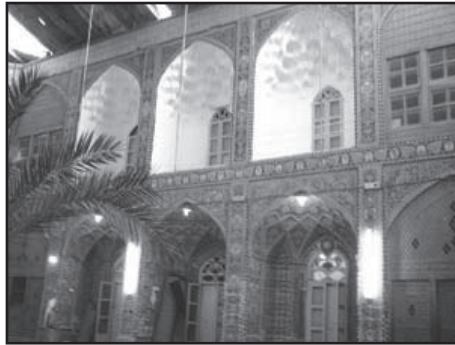
لوحة (٢٢): واجهة المجنبة الجنوبية المطلة على الصحن الكبير - مدرسة اليزدي
