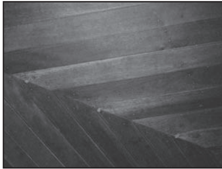
لوح (٤٢): طريقة رصف ألواح السقوف بالطريقة الشيطانية - مدرسة اليزدي
