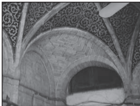
لوح (١٢): الحنايا الركنية والتي تعلوها المثلثات الكروية - مدرسة اليزدي
