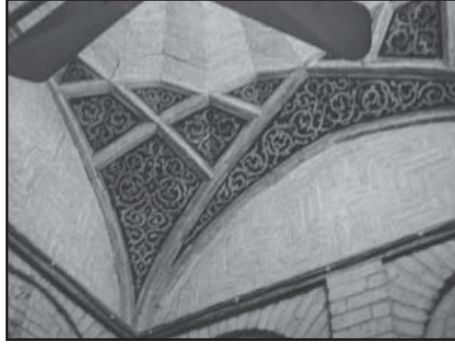
لوح (٥): سقف مدخل المدرسة وفيه المثلثات الكروية المكسية بالقراميد الخزفية والقبة المضلعة
