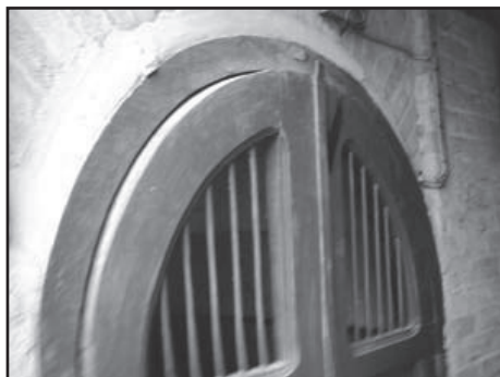
لوح (١٣): بوابة السرداب التي يعلوها عقد نصف دائري - مدرسة اليزدي
