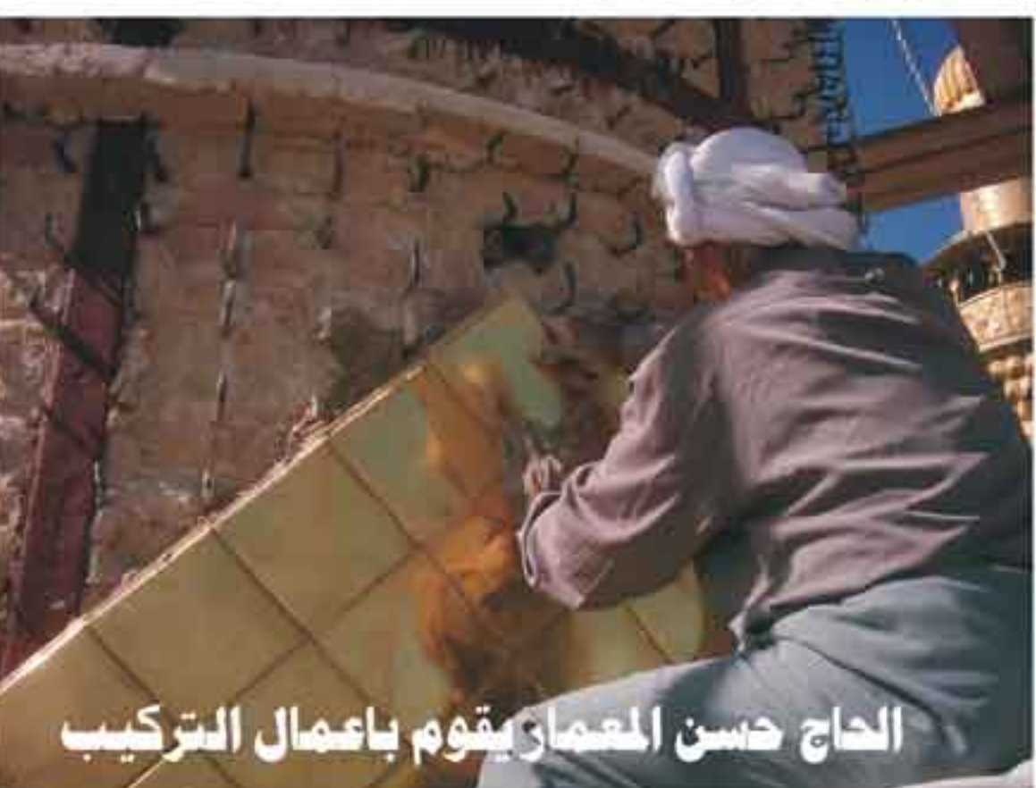
الحاج حسن المعمار يقوم بأعمال التركيب
